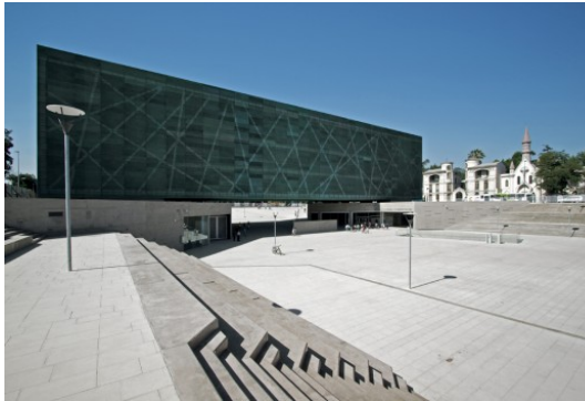
Vue du bâtiment en perspective du nord au sud. 58
